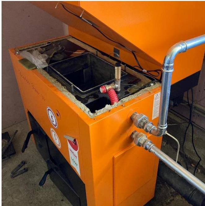
Очистить щеткой и пылесосом камеру теплообменника, сначала верх, затем - низ
