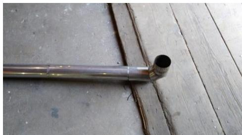
Присоединить дымоход к дымососу, уплотнив стыки термостойкой фольгированной лентой.
