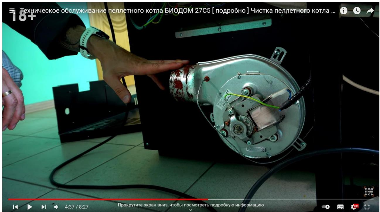
Открутите 3 самореза и отсоедините дымосос от корпуса, (предварительно отметив маркировку контактов).
