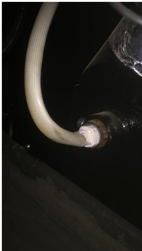
**Правильно: винт поджимает белую рубашку, обойма гильзы выдвинута наружу на 3 мм**
