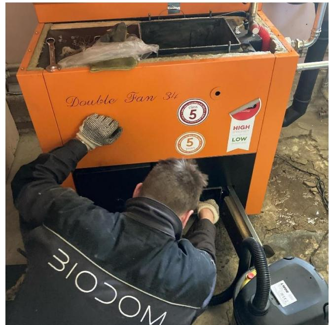
Вставить на место, ось встrijхивателя, снова собрать встrijхиватель, соединив его с рамкой и пружинами так же как было. Подвесьте рамку на чём-нибудь, над теплообменником (пара ключей) и затем навешивайте пружины по одной.
