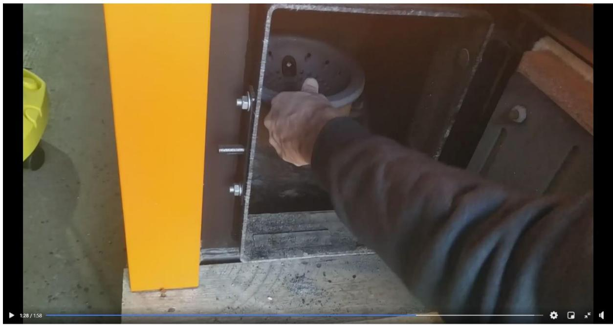
5. Подергать черную ручку вниз, на корпусе и пропылесосить правое отделение под теплообменником, и далее до вентилятора дымососа - аккуратно, чтобы не повредить лопатки вентилятора!
